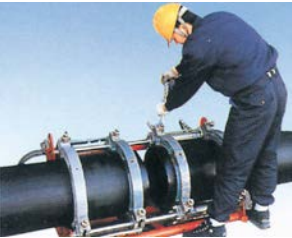
융착기에 관을 장착한 후 면취기를 이용하여 관의 단면을 일정하게 깎아낸다.
